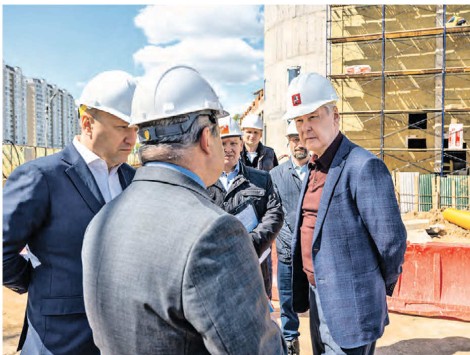
Мэр Москвы Сергей Собянин (на фото справа) осматривает строящуюся детскую школу искусств в поселении Московский
