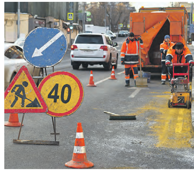
На одной из московских улиц оградил часть дороги на время проведения ремонтных работ
