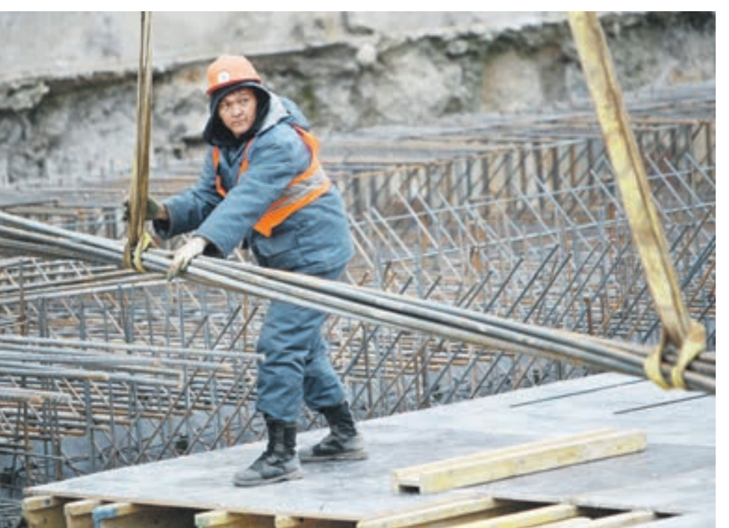
22 октября 12:57 Строительство станции «Некрасовка» Кожуховской линии метро. Всего к работам на этой ветке сегодня привлечены более двух тысяч человек
