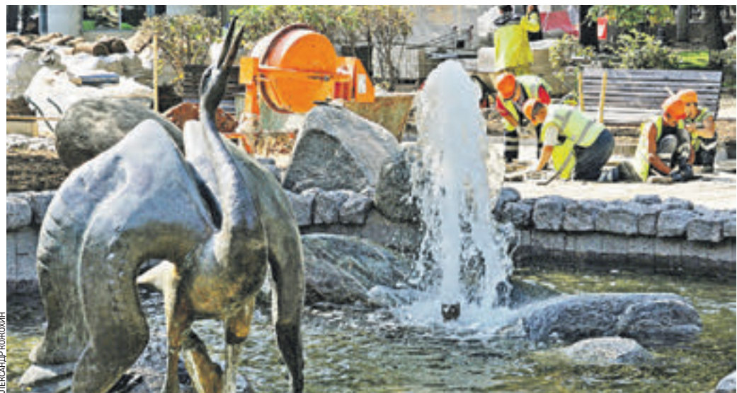
18 августа 10:30 Специалисты Гормоста обновляют мощение на площади вокруг фонтана и маскируют швы на плитке, под которой прошли кабели для декоративной подсветки
