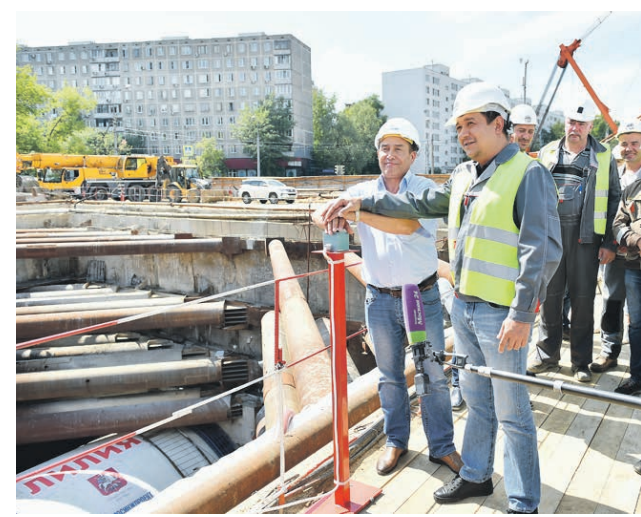
Запуск десятиметрового тоннелепроходческого щита «Лилия» на станции метро «Юго-Восточная». Фото 2018 года
