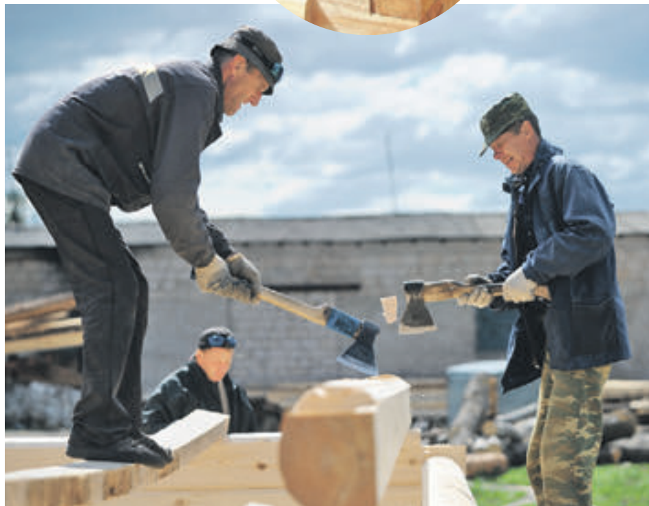
Подмосковные плотники работают по старинке — топором
