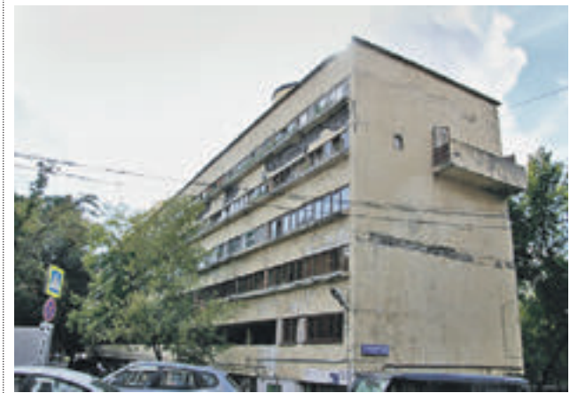
17 августа 2016 года. Дом Наркомфина на Новинском бульваре
