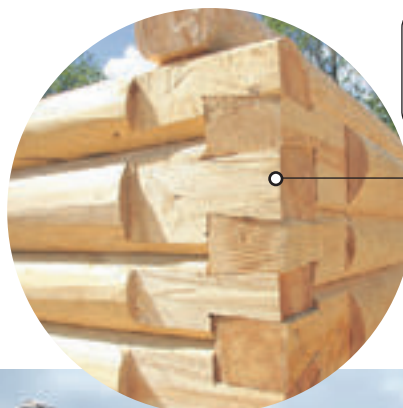
Если место соединения двух бревен выполнено правильно, в доме и зимой сохранится тепло
