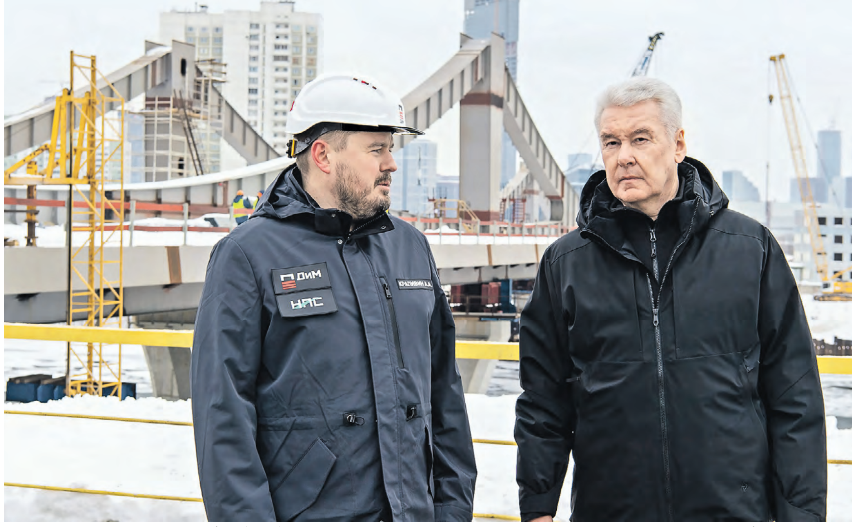
21 февраля. Мэр Москвы Сергей Собянин (справа) и генеральный директор компании-подрядчика Алексей Крапивин осмотрели строящийся автомобильный мост в районе улицы Мяснищева, который свяжет Мневниковскую и Филевскую поймы
