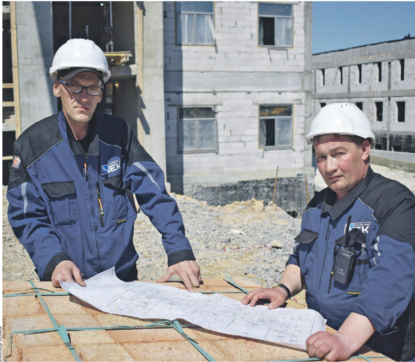
Вчера 13:51 Мастер по работе с сантехникой горячего и холодного водоснабжения Павел Никитин (слева) и производитель работ Вячеслав Попов на стройке перинатального центра в Донецке
