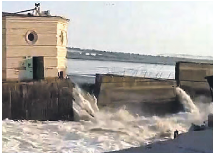
Разрушенная Каховская ГЭС
