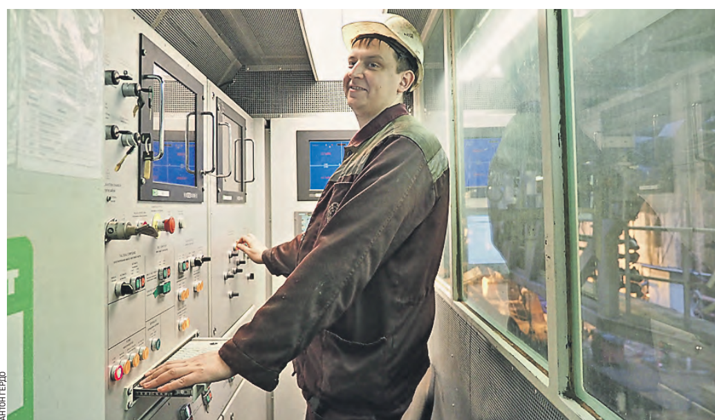
15 октября 2020 года. Подготовка тоннельно-проходческого комплекса «Татьяна» к старту. Оператор щита Сергей Коновалов проверяет все системы
