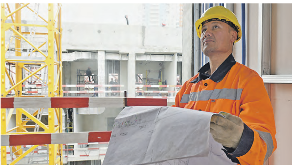
28 июля 14:48 Строитель Дамир Колпачи осматривает ход работ по возведению физкультурно-оздоровительного комплекса в Некрасовке
