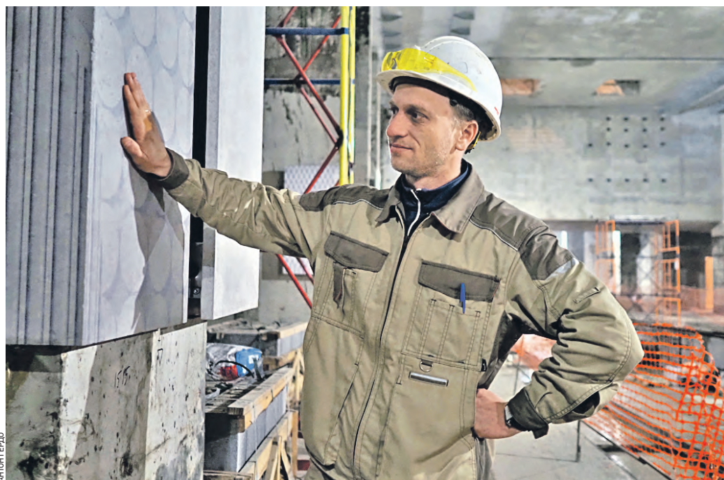
1 мая 2021 года 13:40 Заместитель главного инженера компании-подрядчика Валентин Мороз осматривает основные конструкции станции «Терехово»
