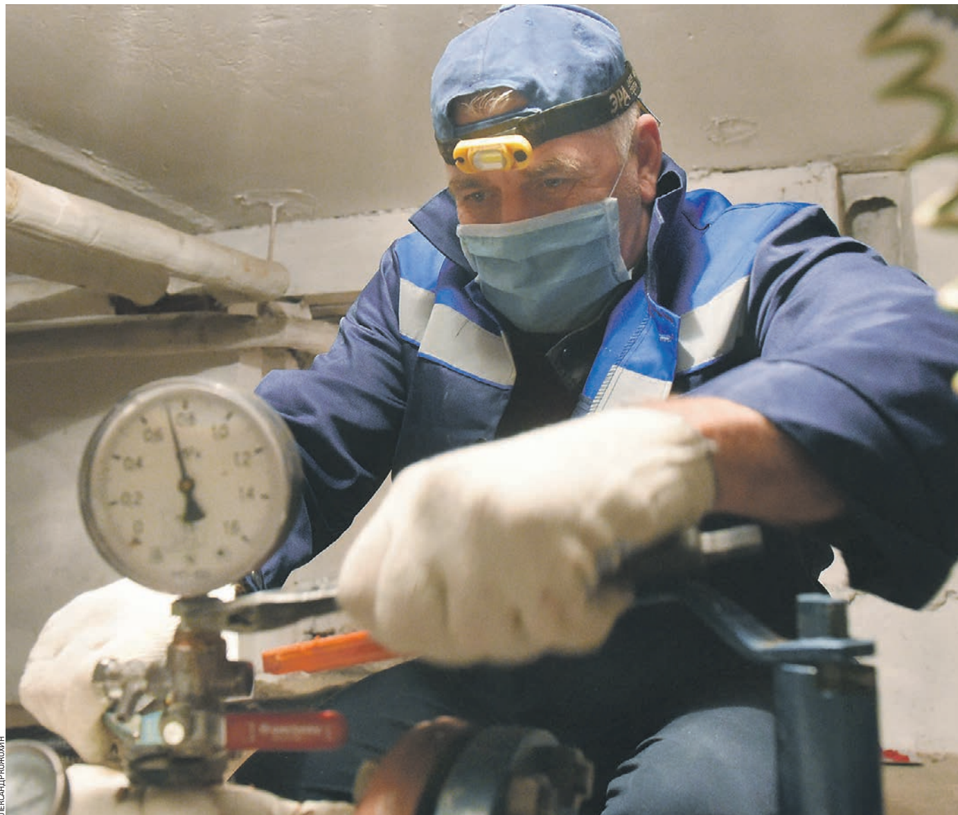
13 мая 10:20 Слесарь ГБУ «Жилищник района Чертаново Центральное» Михаил Черней меняет манометр в подвале дома № 7, корпус 2, по улице Красного Маяка
