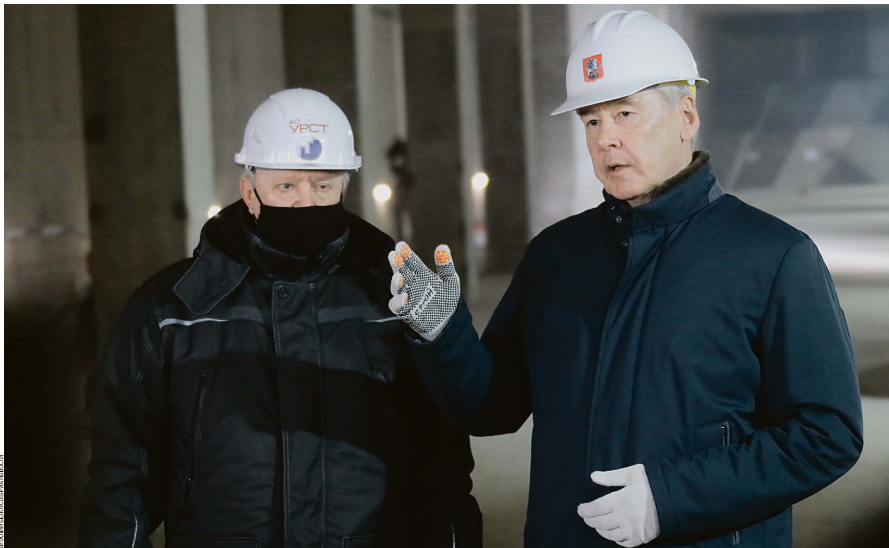
Вчера 11:07 Мэр Москвы Сергей Собянин (справа) и руководитель Управления развития строительных технологий Дмитрий Герасимов осматривали строящуюся станцию «Славянский мир» Троицкой линии метро. Новая ветка будет самой протяженной в столице
