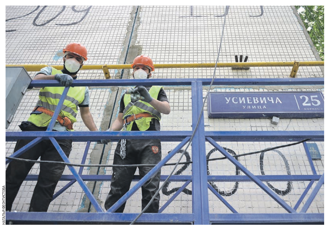
19 августа 13:31 Рабочие готовятся к снятию облицовочной плитки. Предварительно каждую панель на фасаде пронумеровали, чтобы контролировать поэтапное выполнение процессов
