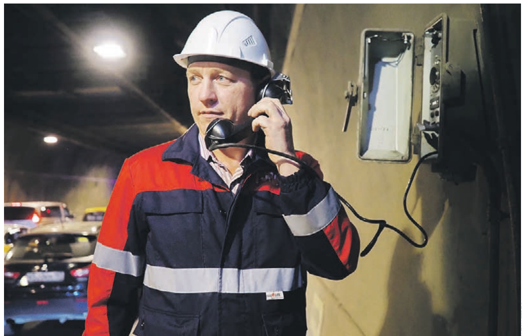
21 августа 11:23 Главный инженер участка «Гормост-Лефортово» Сергей Кулагин проверяет систему связи в Лефортовском тоннеле
