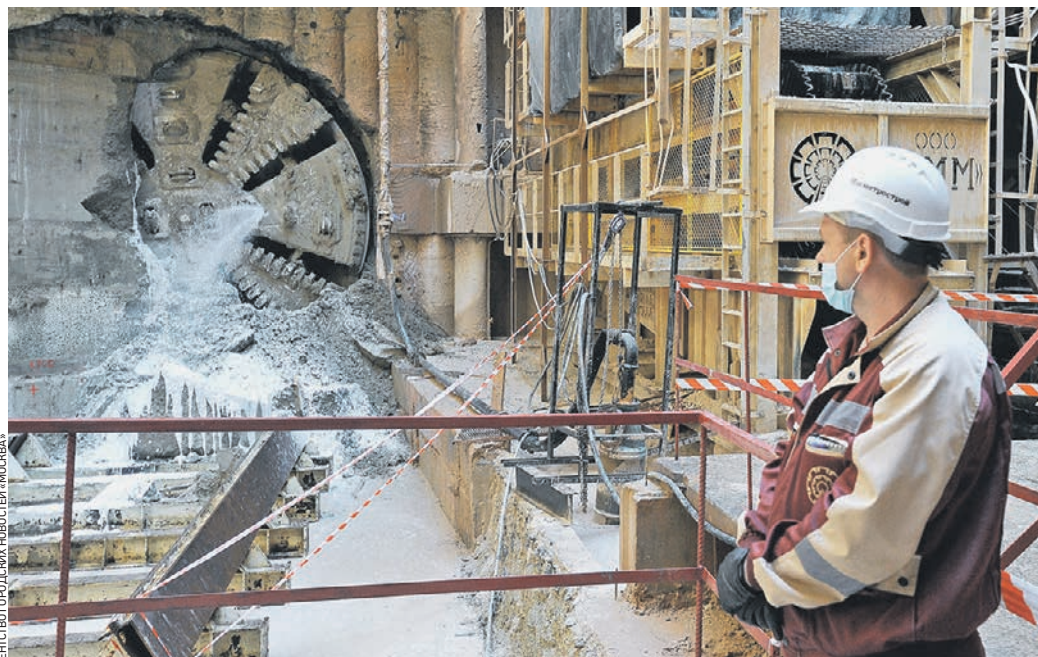
18 июня 12:09 Тоннелепроходческий щит «София» завершает проходку правого перегонного тоннеля между станциями «Сокольники» и «Рижская» Большой кольцевой линии метро
