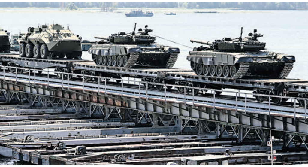
21 августа 2019 года. Военные железнодорожники на учениях в ЦВО рекордно быстро перебрали мост через Волгу длиной в 3 километра
