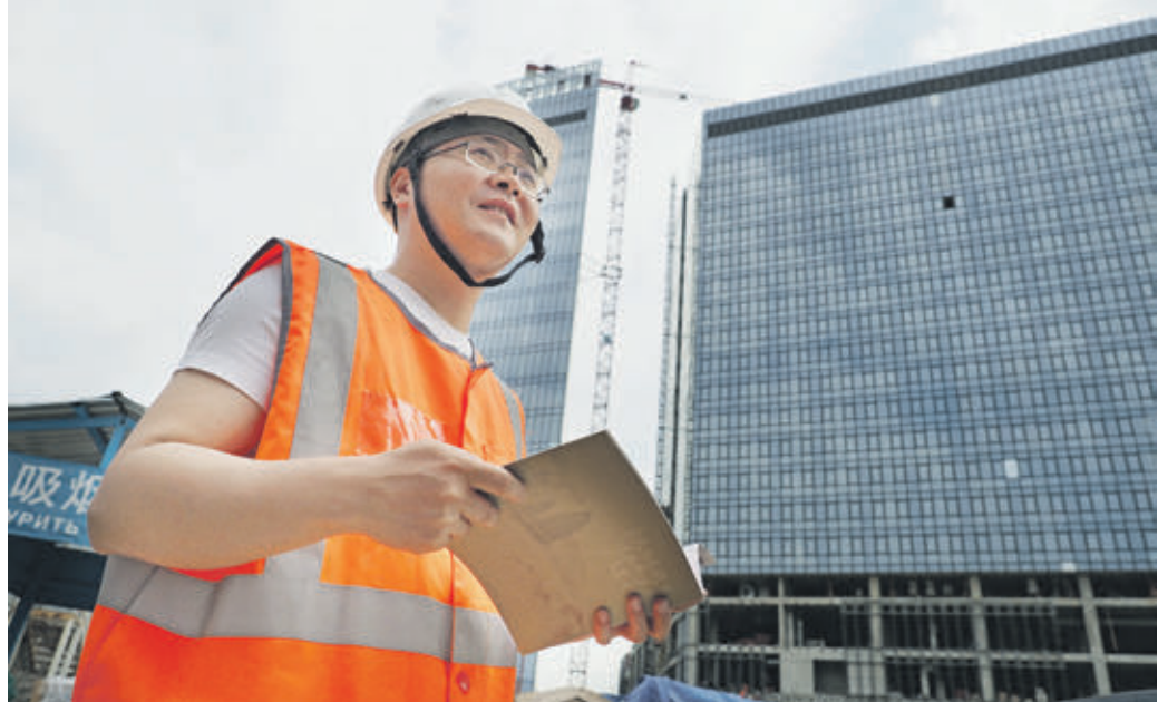
Вчера 11:40 Китайский специалист Чжан Хунбин следит за ходом работ при возведении гостиницы в «Парке Хуамин»
