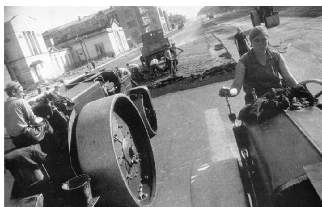
1930-е годы. На Большой Калужской улице укладывают асфальт. Именно в этот период началось массовое асфальтирование дорог столицы
