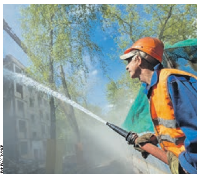
19 мая 11:30 Рабочий Алексей Макаров струей воды сбивает пыль при демонтаже пятиэтажки
