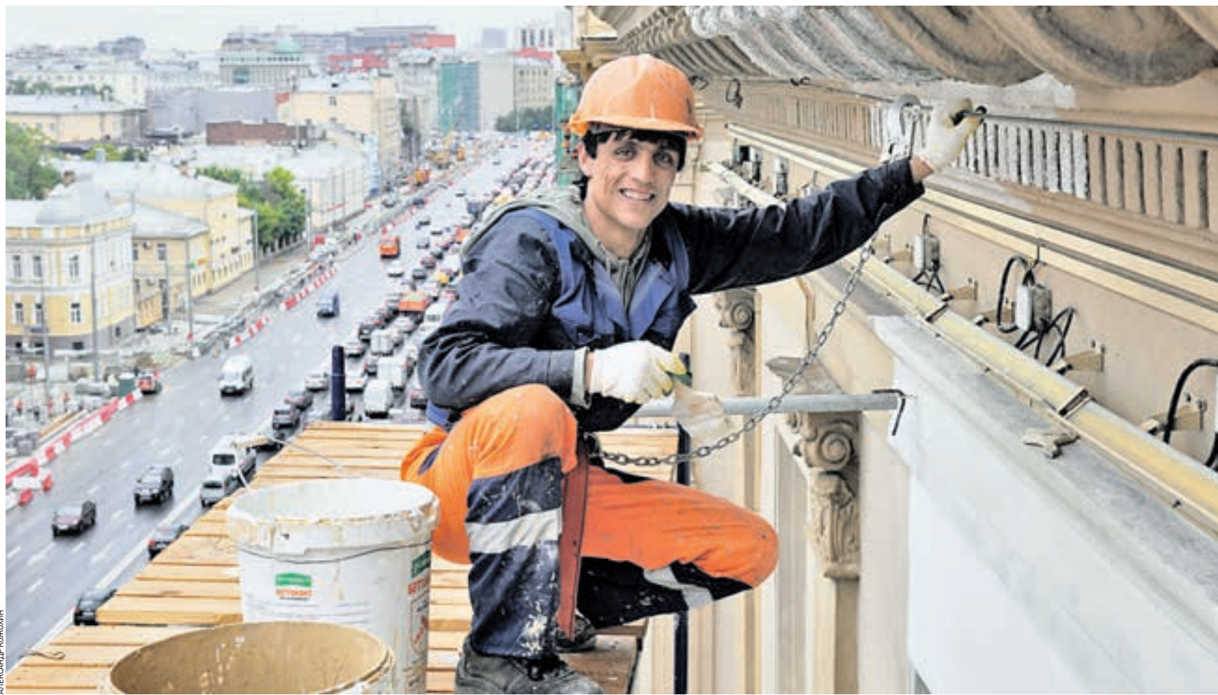
Вчера 12:30 Рабочий Зайдулло Абдуллаев ремонтирует фасад дома № 13/3 по Садовой-Черногрязской улице. Все хрупкие архитектурные элементы здания рабочие бережно красят и наносят водоотталкивающий слой
