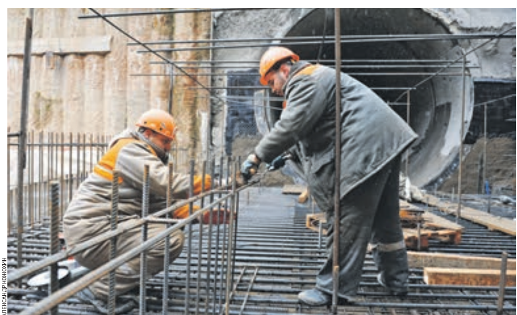
4 ноября 2016 года 16:10 Рабочие Юрий Волков (слева) и Евгений Резник собирают арматурный каркас на строящейся станции «Мичуринский проспект» Калининско-Солнцевской линии метро
