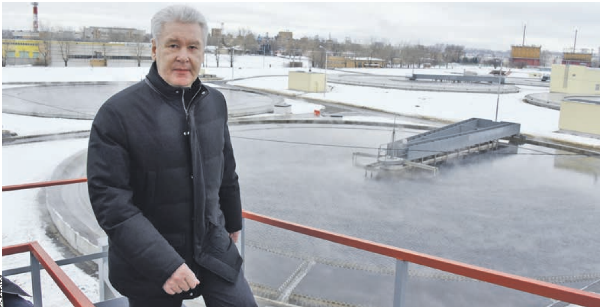
Вчера 11:18 Мэр Москвы Сергей Собянин осматривает Курьяновские очистные сооружения. Реконструкция позволила повысить качество очистки воды, оптимизировать численность персонала за счет автоматизации, обновить основные конструкции очистных сооружений и тем самым обеспечить их надежную работу на следующие 50 лет
