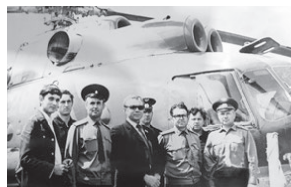
1974 год. Александр Куприянов (крайний слева) со строителями железнодорожных войск у Дуссе-Алиньского тоннеля.
