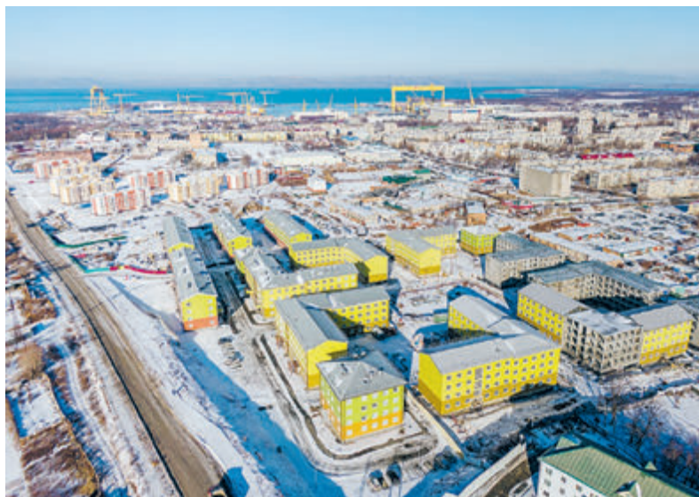
В городе Большой Камень ведется строительство жилых домов для работников судоверфи.
