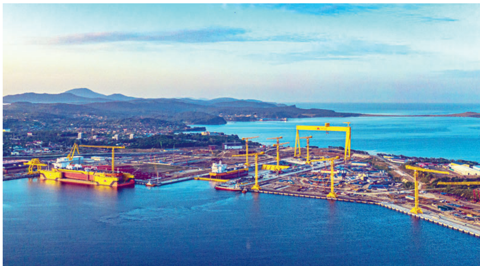
Над доком возвышается желтый кран-исполнитель «Голиаф», который позволяет перемещать стальные блоки весом до 1200 тонн.
