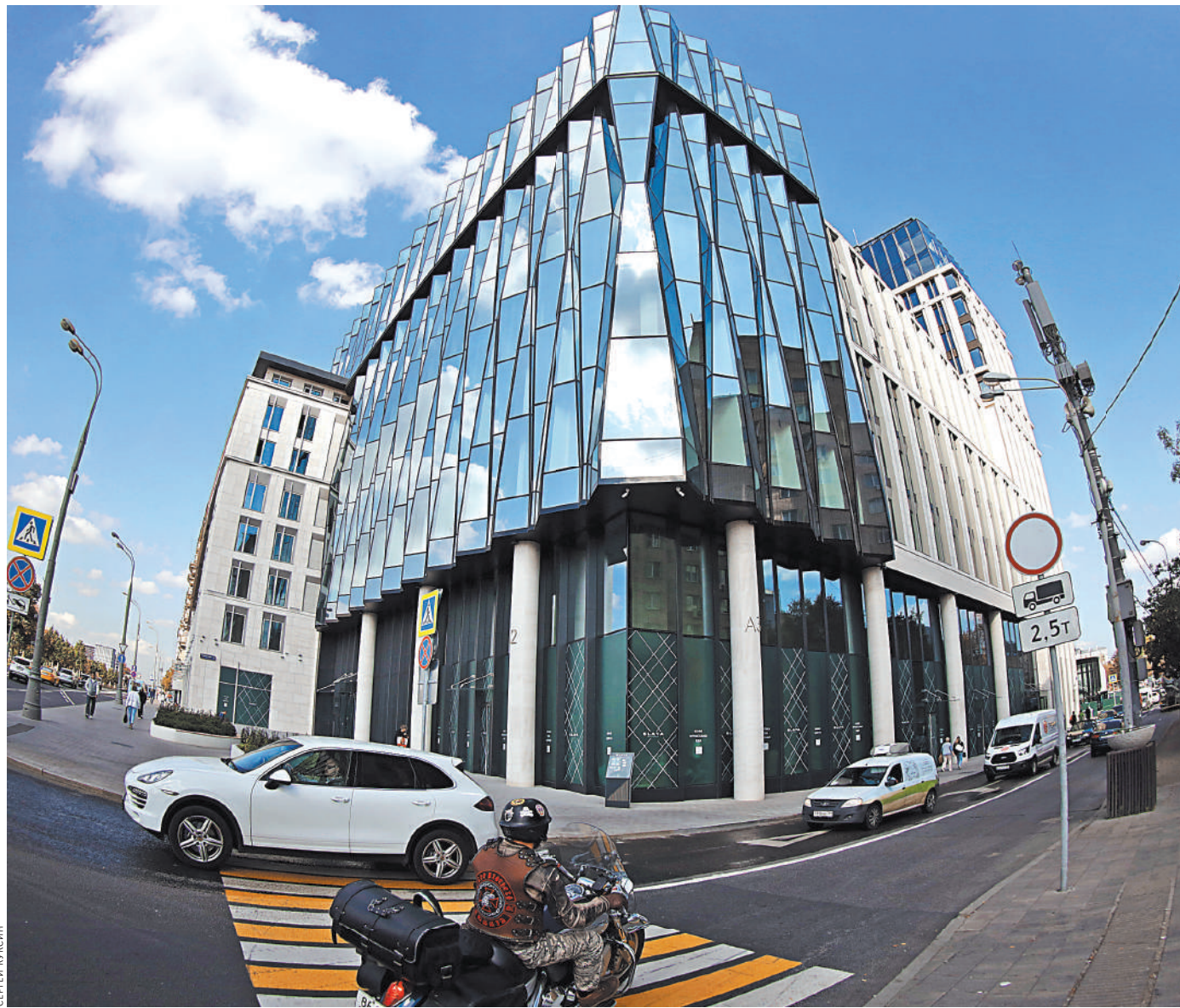
На фасаде дома на Ленинградском проспекте — стеклянная гармошка, которой гордятся именитые архитекторы.
