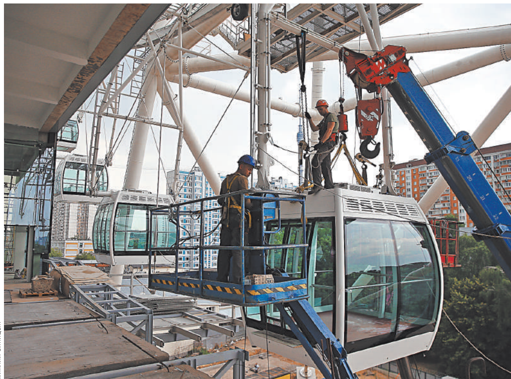
Монтажники уже установили 16 из 30 кабин. Каждая весит больше четырех тонн.
