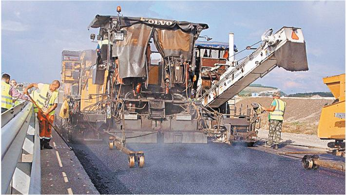
Особое покрытие, специально разработанное для «Тавриды», наносят на полотно дороги два асфальтоукладочных комплекса, а следом за ними асфальт утюжат четыре катка.
