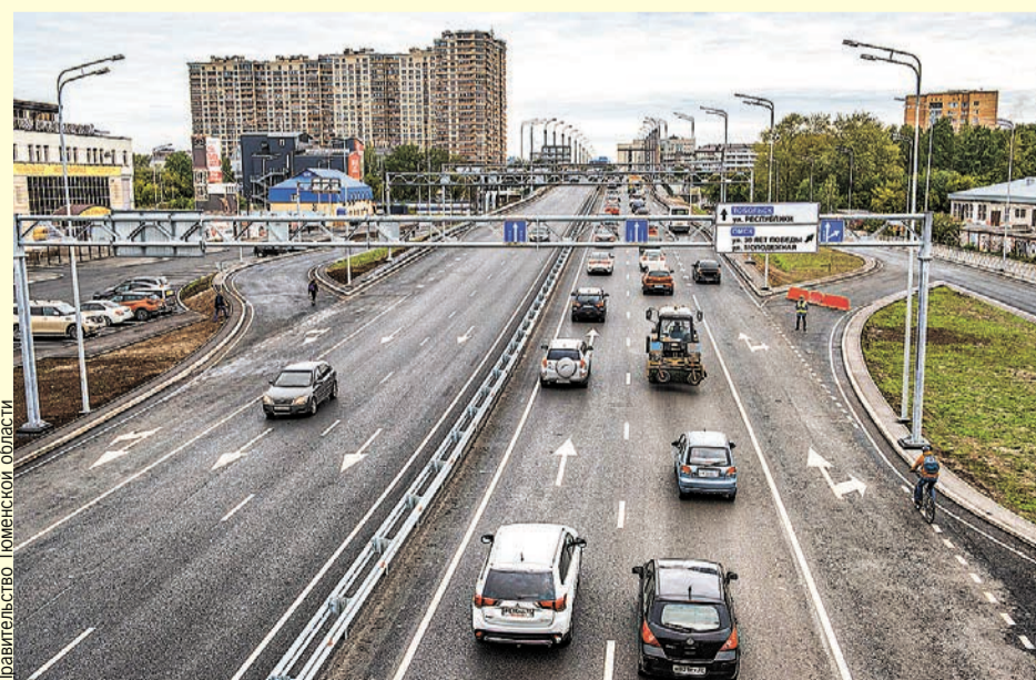
Строительство обошлось бюджету в 2 миллиарда рублей.
