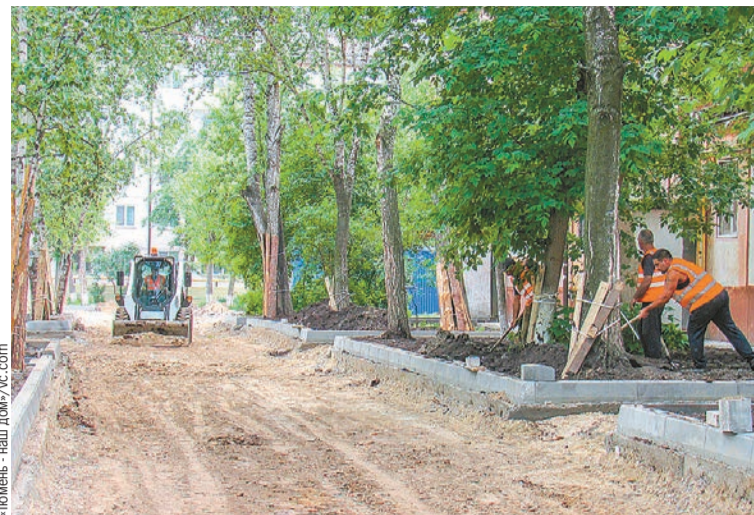
После сноса аварийных деревьев будет высажено более 50 деревьев и 200 кустарников.
