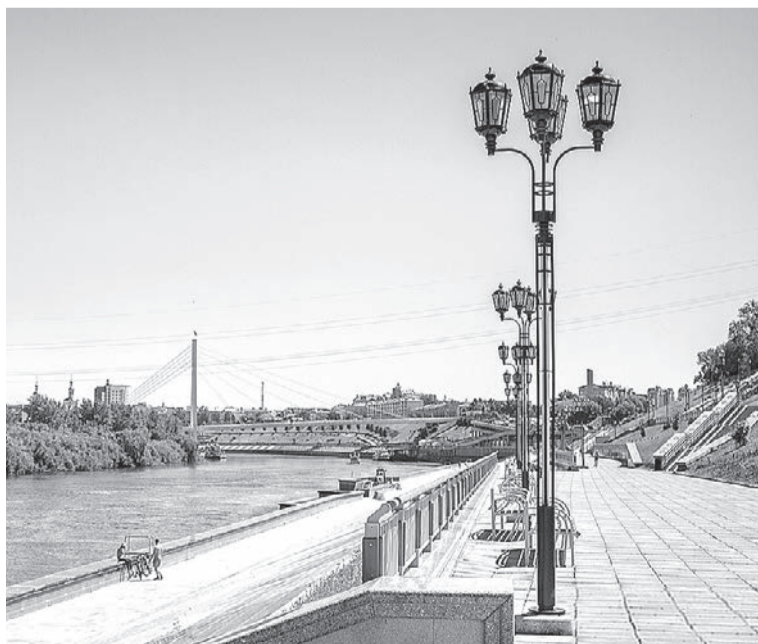
Теперь городскую набережную ждет ремонт.
