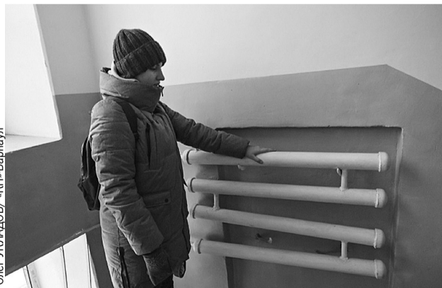
Средства были выделены на капремонт системы теплоснабжения в доме №57 по улице Лепсе.
