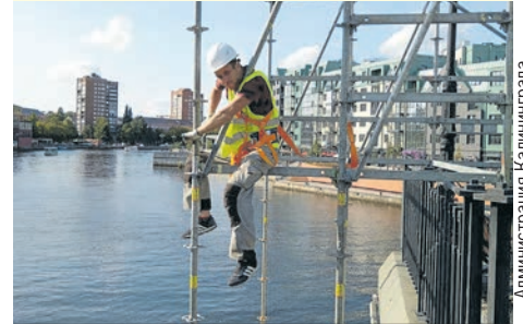
Рабочие готовятся к установке архитектурной подсветки.
