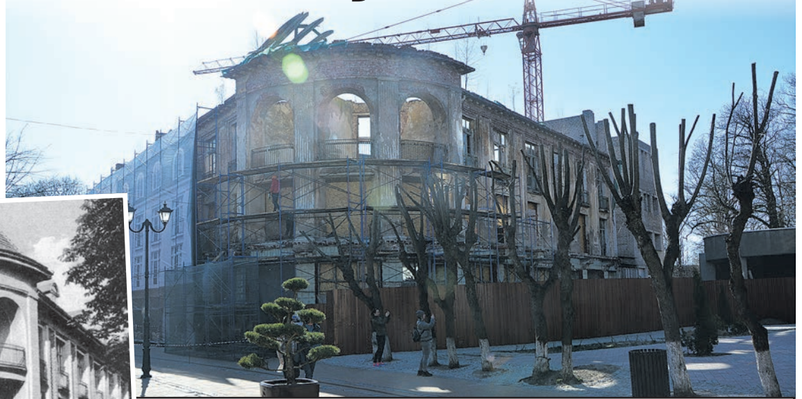
До окончания работ еще очень далеко.
