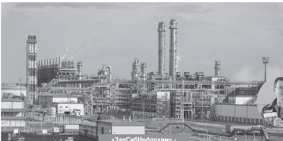
«ЗапСибНефтехим» - крупнейший нефтехимический комплекс России.
