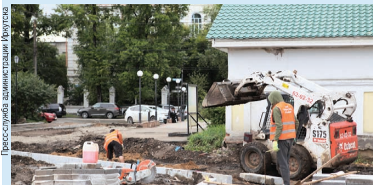
Работы выполнены на 80%.
