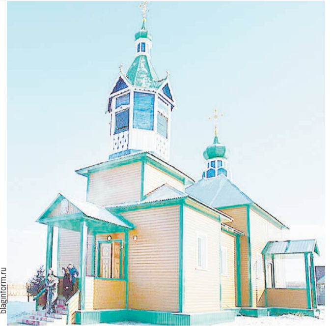
Здание восстановили на старом фундаменте.
