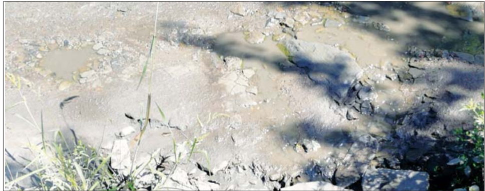
Дорогу, которую сделали размывает — щебень смывается в балку и ещё больше её засоряет. Фото Виктории Локошко.
