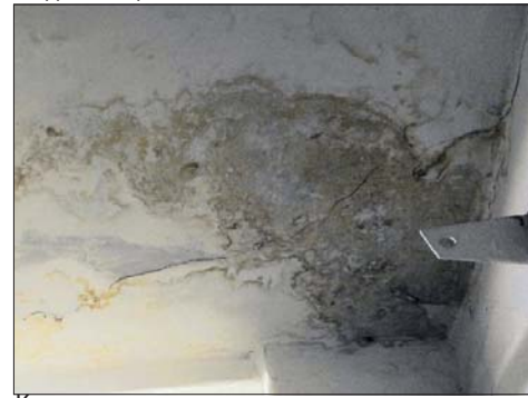
Крыша в здании протекает.
