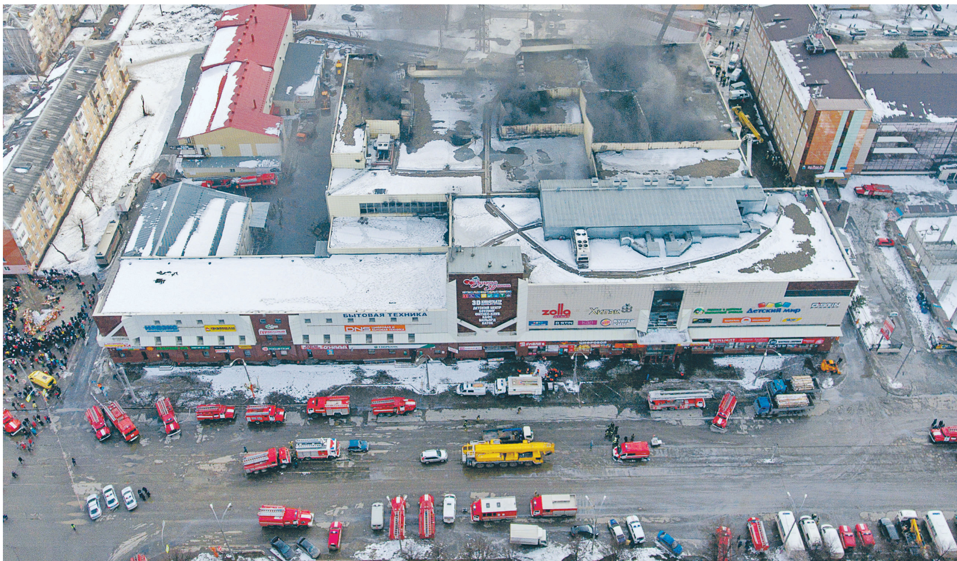
О том, что в ТРЦ началось возгорание, посетителей не предупредили: противопожарную сигнализацию было слышно только на первом этаже, а аварийные выходы были заперты
