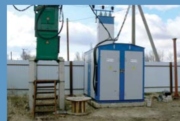
Трансформаторная подстанция
